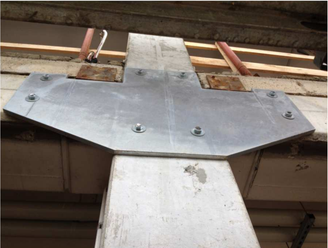
Intervento di adeguamento sismico presso un edificio scolastico (scuola secondaria Volta – Cologno M.)
