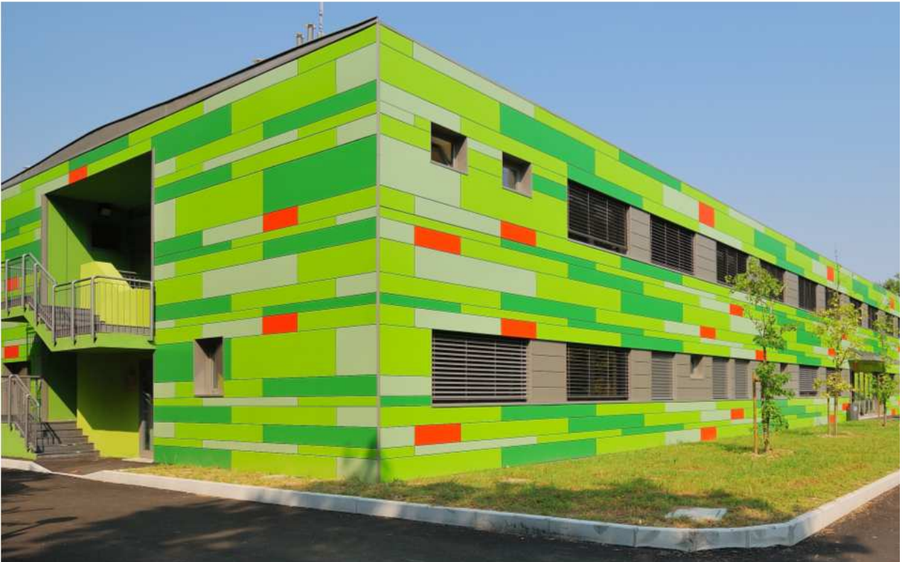
Riqualificazione energetica ed adeguamento sismico edificio scolastico a Cologno Monzese
