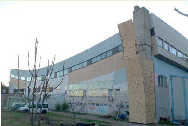
3_Vista edificio lato ferrovia
