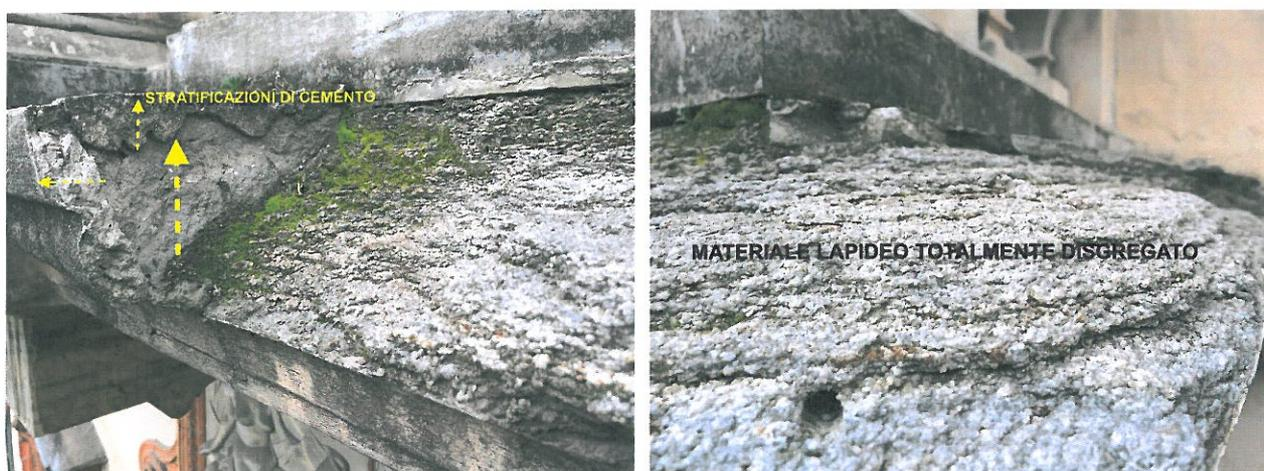
Balaustra colonnata - pietra di sarnico o simile - stato di conservazione buono: la balaustra si presenta ampiamente fessurata a causa del dissesto statico ma il materiale costitutivo risulta in buono stato; alcuni depositi incoerenti rivestono probabili depositi più compatti e qualche piccola localizzata crosta nera.
