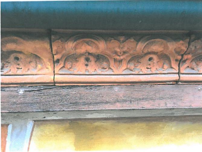
Tavelle e modanature decorate in cotto - stato di conservazione discreto ma con molta probabilità totalmente alterato da precedenti interventi di pulitura e manutenzione: le tavelle sembrano essere state avvitate ad una struttura di sostegno, attualmente non visibile, durante precedenti lavori di restauro; si individuano facilmente numerose grosse viti a taglio.
