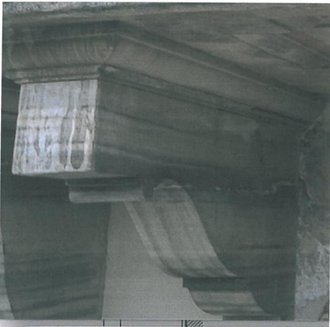
Piano di calpestio - lastra in granito o serizzo - stato di conservazione pessimo: la lastra si presenta totalmente ricoperta da spalmature di cemento che in alcuni casi arrivano a superare lo spessore di 7/8 cm.; sotto questo spesso rivestimento troviamo il materiale costitutivo totalmente disgregato e senza più alcuna compattezza, la granulometria si scompone per la quasi totale assenza della materia legante.
