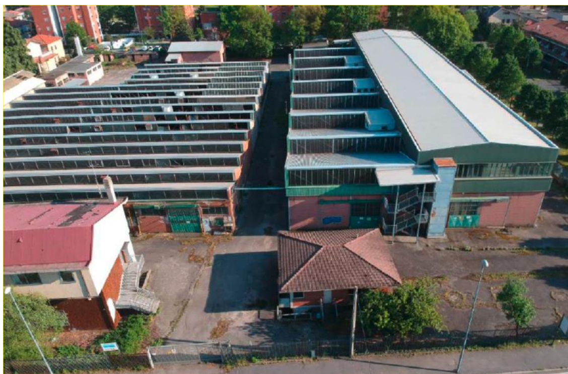
Edifici dismessi esistenti
