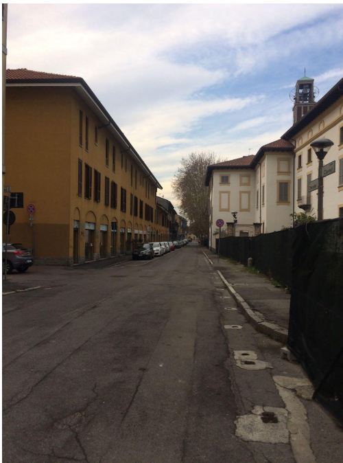
Foto n.3 tratto stradale di via Omodei
