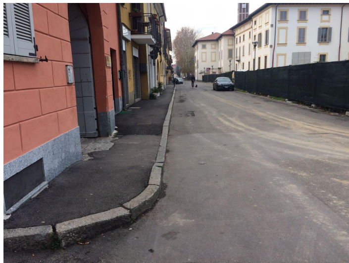
Foto n.2 tratto stradale di via Omodei
