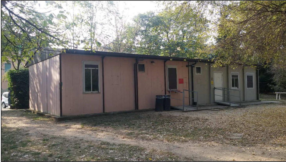
Angolo nord-est e fronte nord
