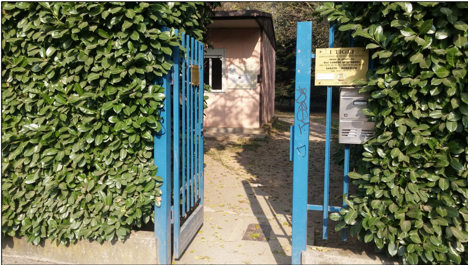
Accesso da strada e angolo sud-est
