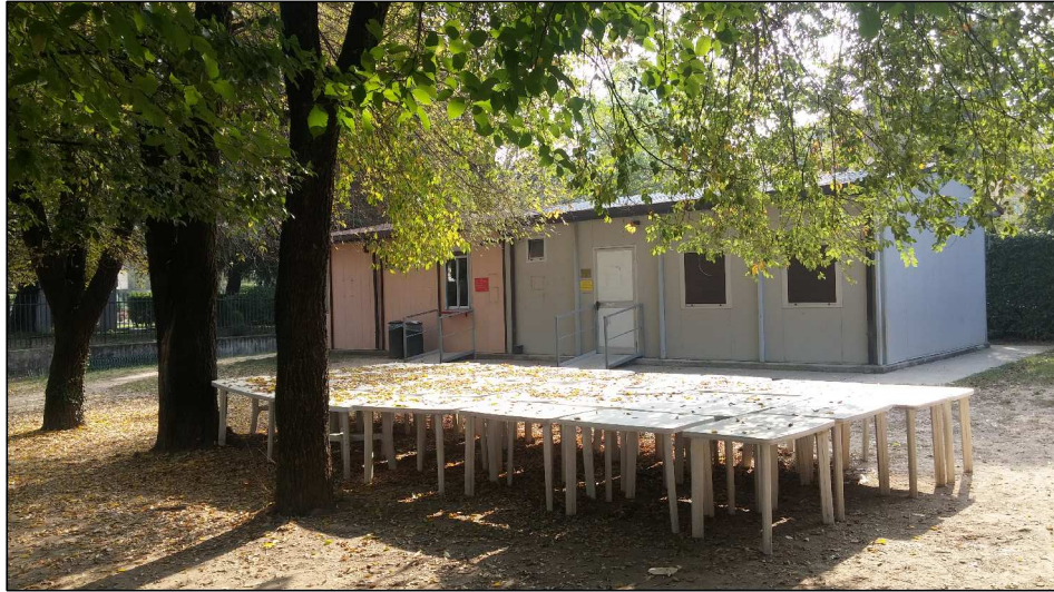
Fronte nord e angolo nord-ovest
