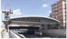
vo l'inquinamento acustico e il rumore. La galleria sarà poi illuminata grazie a pannelli fotovoltaici posti su una parte della copertura in grado di captare, utilizzare e convertire l'energia solare.
