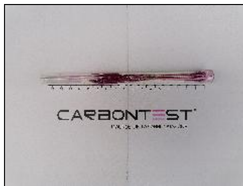
Foto 3.2 - Particolare carbonatazione - Pilastro Edificio 2
