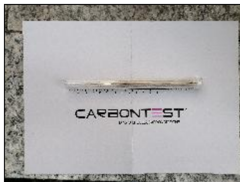
Foto 6.2 - Particolare carbonatazione - Trave Edificio 3
