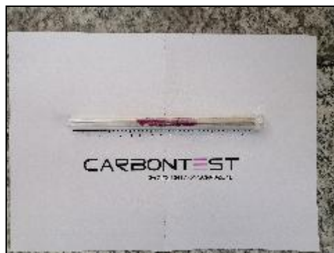
Foto 5.2 - Particolare carbonatazione - Pilastro Edificio 3
