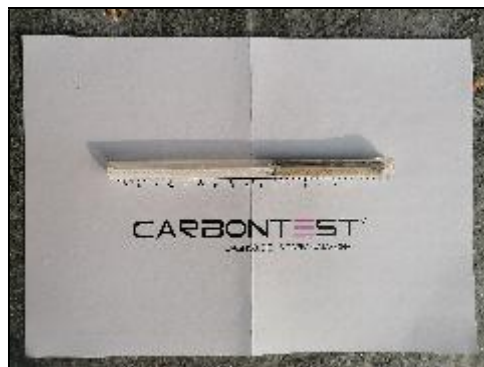
Foto 2.2 - Particolare carbonatazione - Trave Edificio 1
