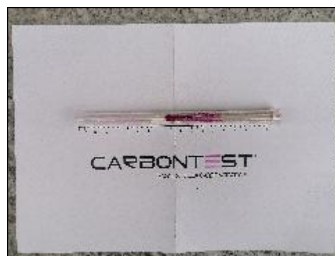
Foto 4.2 - Particolare carbonatazione - Trave Edificio 2
