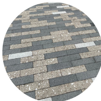
Pavimentazione in autobloccanti
