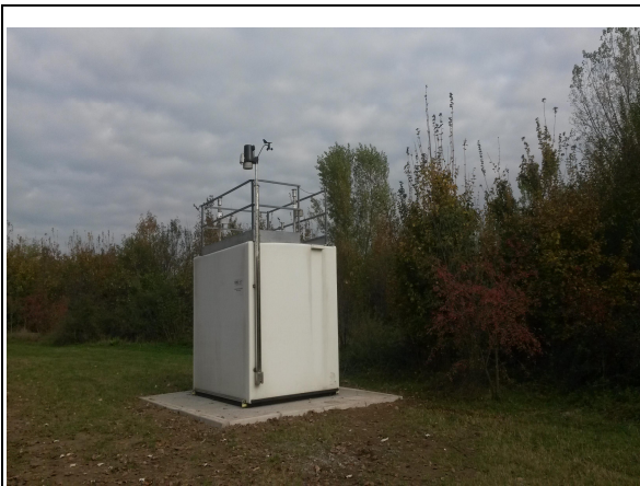
Foto 1: Centralina via per Bresso
