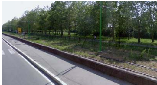
Metrotranvia in via Gorki
