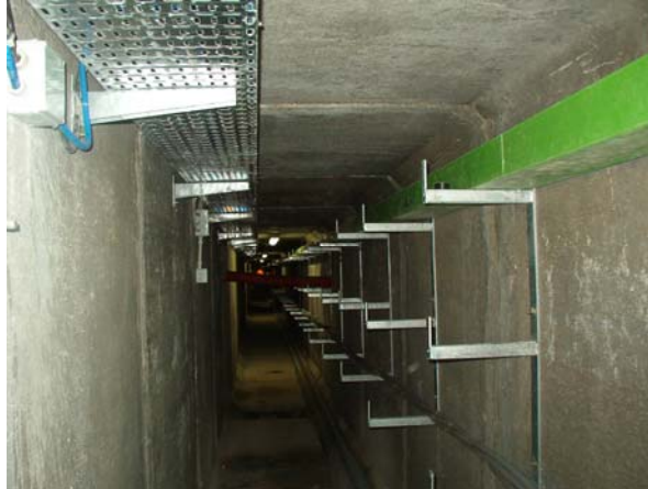
Cunicolo tecnologico in fase di approntamento
