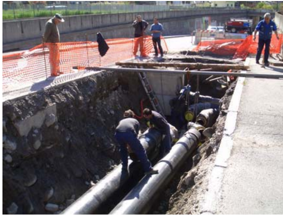
Posa di tubi del teleriscaldamento
