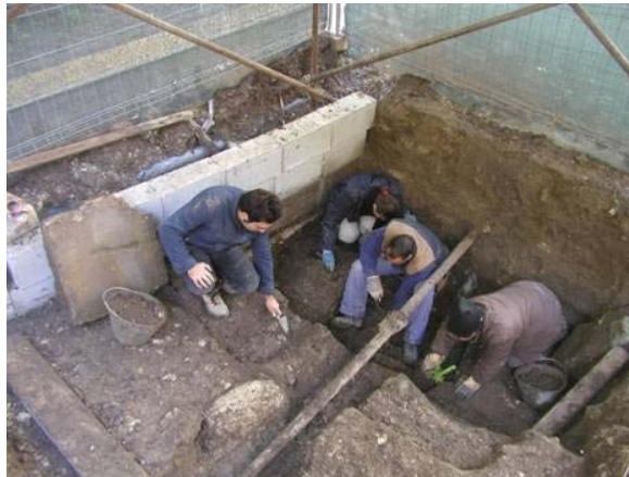
Intervento di manutenzione straordinaria sui sottoservizi
