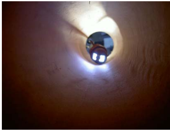
Ingresso di una telecamera in tubazione
