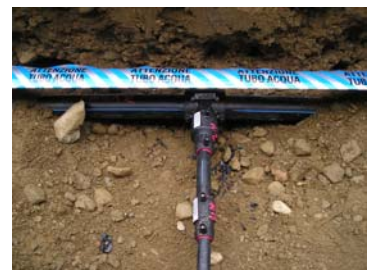
Esempio di posa tradizionale dei sistemi a rete del sottosuolo
