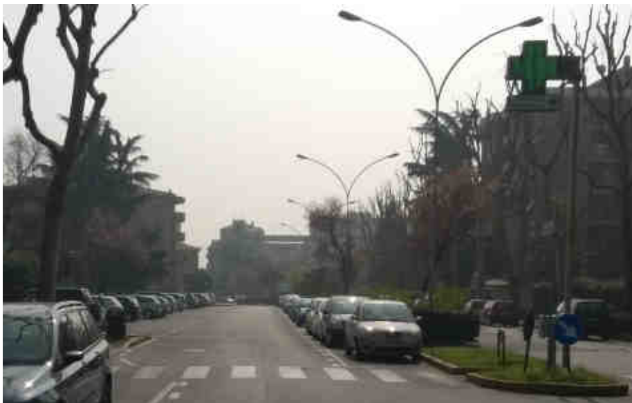
Via Monte Santo: impianto illuminazione pubblica esistente
