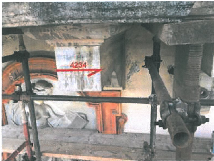
Trave più interna 20cm di spessore
